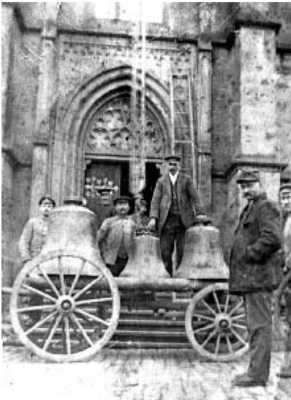
*Ein Bild aus dem Jahre 1918. Es zeigt die drei Stahlgussglocken, kurz vor dem Installieren. Die kleine Glocke hängt bereits am Seilzug, weil diese an oberster Stelle im Glockenstuhl aufgehängt werden soll. Diese alte Aufnahme stellte uns Otto Diehl zur Verfügung und er erhielt sie von Wilhelm Sauerwein, Uferstraße 1.*
